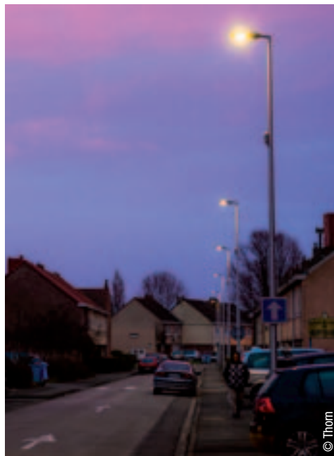
▲ Grande Synthe : rénovation de l'éclairage public en technologie LED dans le cadre du TEP.
