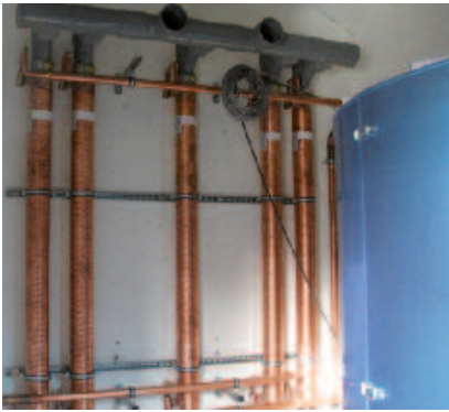
► Installation du système cuve et PAC associé de récupération de chaleur des eaux grises.
