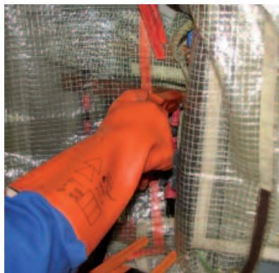
Travaux sous tension sur batteries d'accumulateur.
