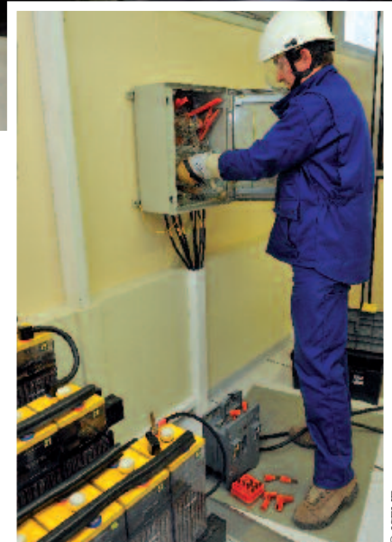
Travaux sous tension sur coffret.
